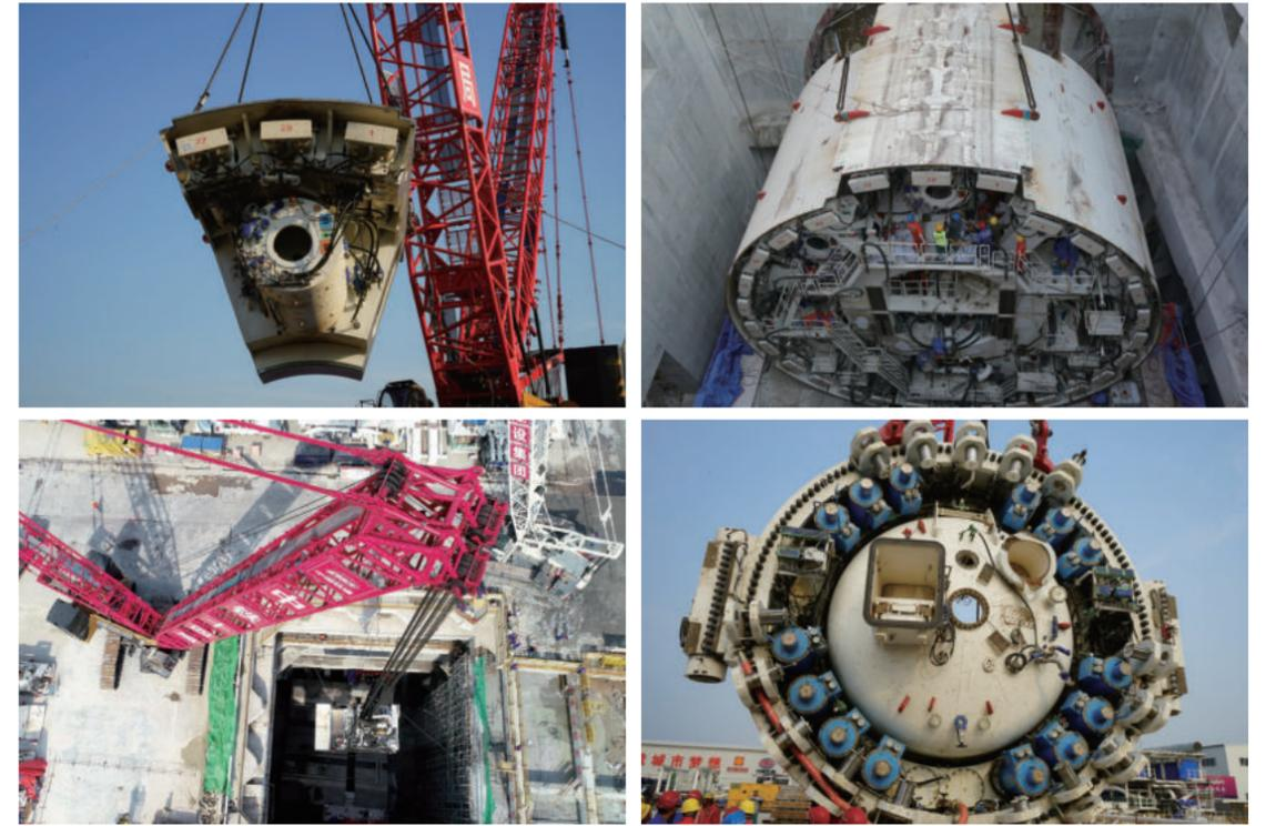
6月27日，由济南城市建设集团和中铁十四局集团联合打造的济南黄河隧道工程“黄河号”盾构机刀盘开始吊装下井，盾构始发作业进入“倒计时”。
