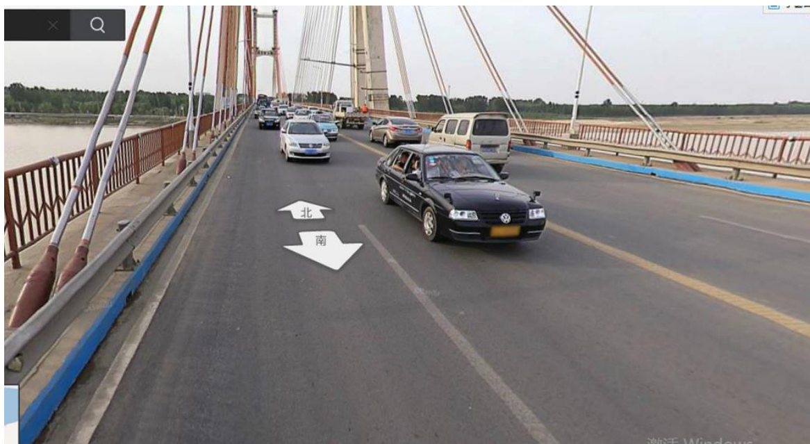
图 6.1-1 G104 济南黄河公路大桥现状
