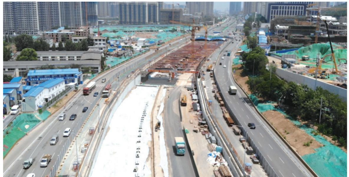
望岳快速路隧道段北起英雄山立交，南至鲁能领秀公馆，全长约2.2公里，主要包含1.5公里暗挖隧道、0.7公里明挖段以及配套综合管廊、排水、道路、专业管线等工程内容，总造价约17.5亿元。这条隧道和普通的穿山隧道不同，地质条件极其复杂，同时还要保证路面车辆通行，工程具有断面大、埋深浅、动荷
